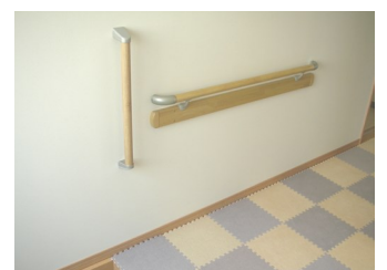
玄関部分後付け手すりの設置例
