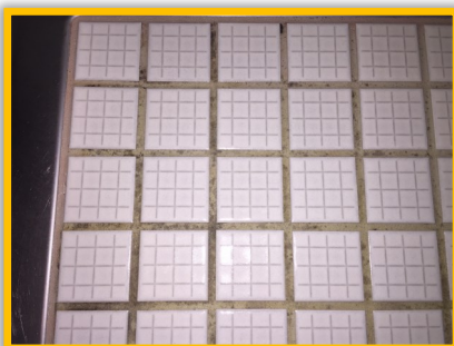
④カビの発生している所にしっかり塗布する
