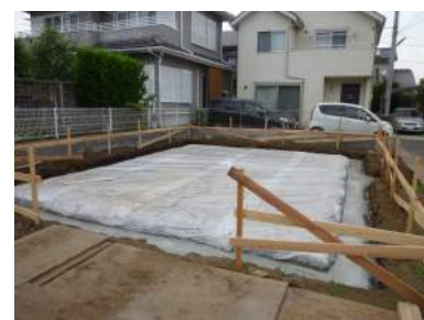
ベタ基礎配筋の前に防湿フィルムを敷込みます
